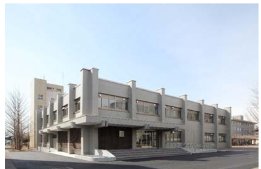
工学部図書館の改修(長野市) 耐震補強及び機能改善整備を行いました。
