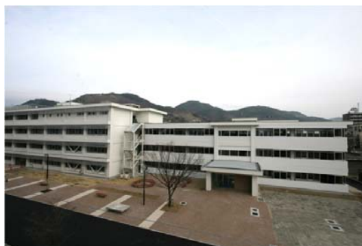
長野(教育)キャンパス人文・美術校舎(講義棟・北校舎)の改修耐震補強及び機能改善整備を行いました。
