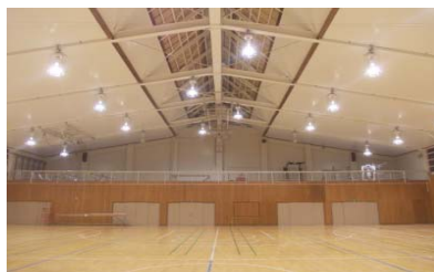
松本キャンパス第一体育館の改修
