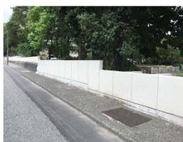
附属松本小学校園囲障の改修
