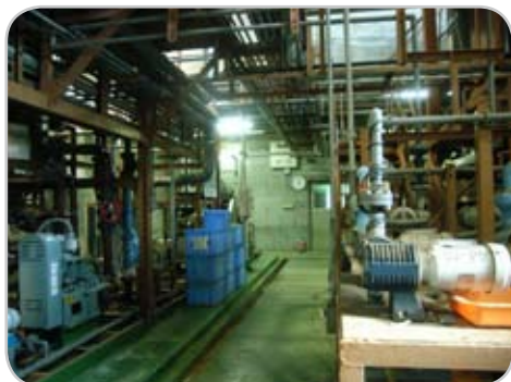
●閉鎖した実験廃液処理施設
