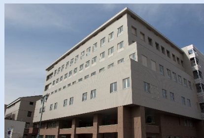
平成30年4月から稼働した包括先進医療棟
