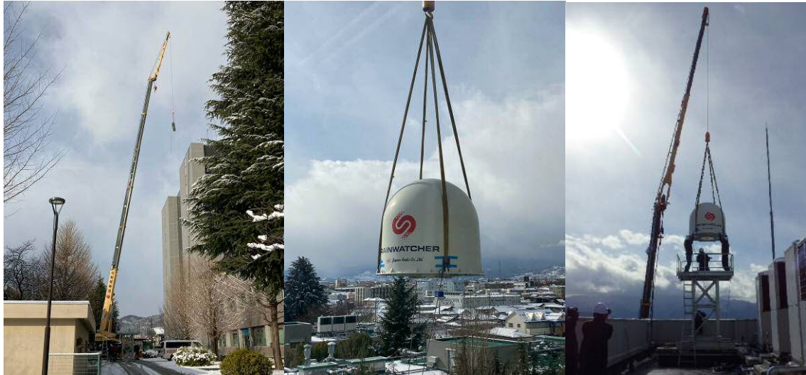
写真1 信州大学工学キャンパス総合研究棟屋上への小型気象レーダ移設 (2021年1月19日)
